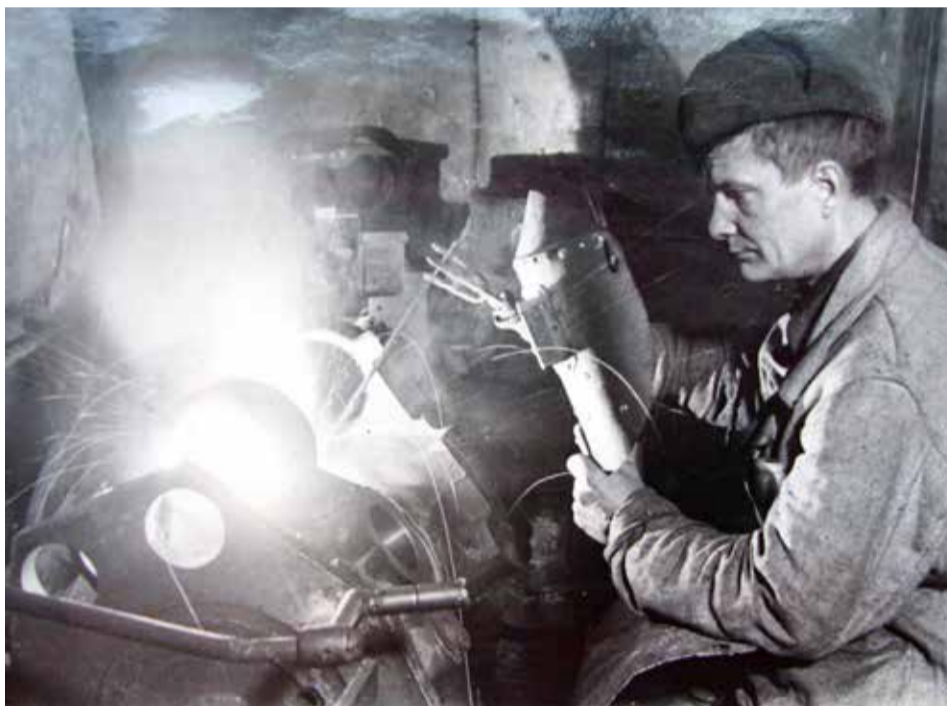
Сварка люльки 122-мм гаубицы
