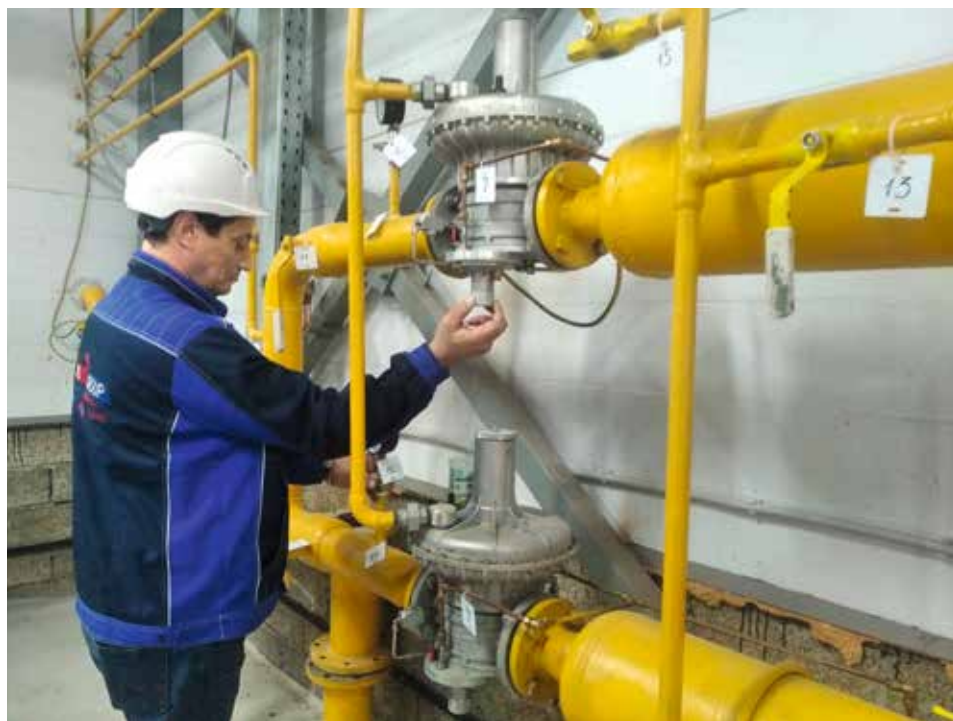
На ИЗ-КАРТЭКС заработала автономная газовая котельная
