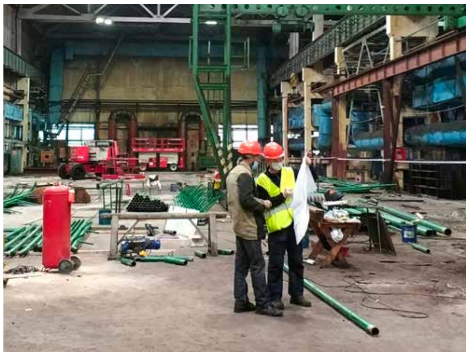
В цехе 13 начался монтаж системы автоматического пожаротушения
