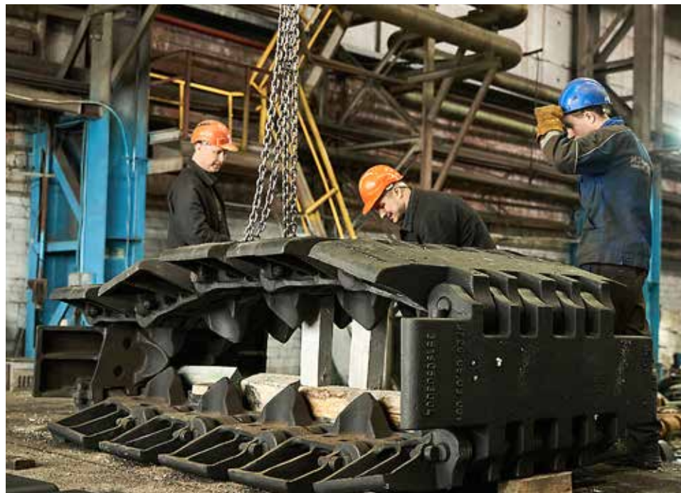
Сборку и комплектацию расходных элементов ходовой части и ковша экскаваторов ИЗ-КАРТЭКС теперь выполняют на одном участке
