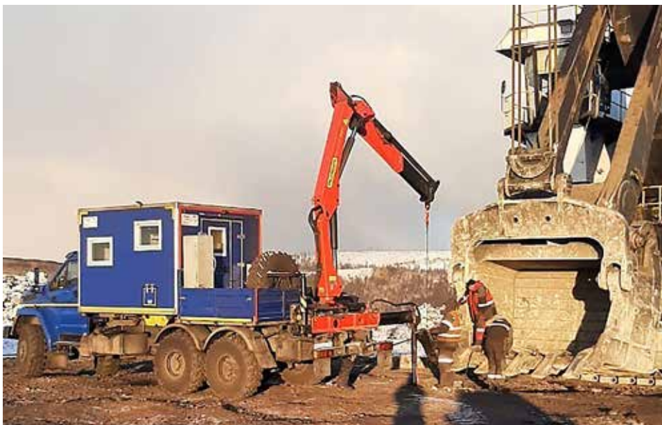
Для замены зубьев ковша на разрезе используют специальную технику
