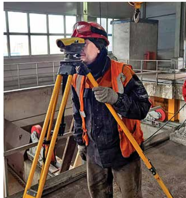
Сборка узлов и деталей вагоноопрокидывателя ВРС-134М проводится с высочайшей точностью
