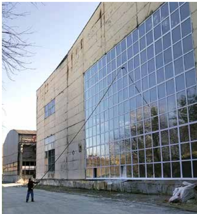
С помощью удочки-шланга можно вымыть окна на уровне 18 м
