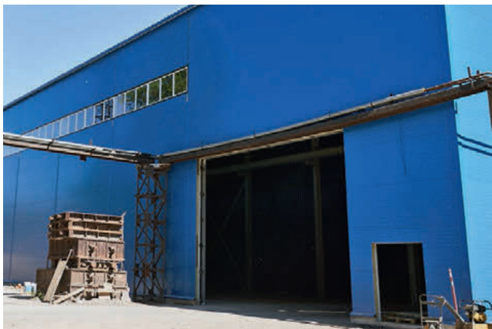
Ведется реконструкция корпусов ЛП, улучшаются условия труда
