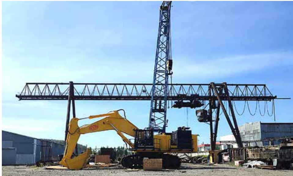
Специалисты сервисного центра завершают монтаж УГЭ-110 в АО «Кузбассразрезуголь»
