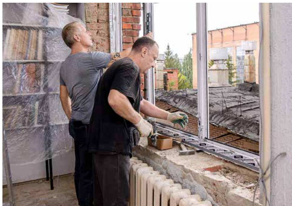
После установки новых окон в кабинетах станет теплее
