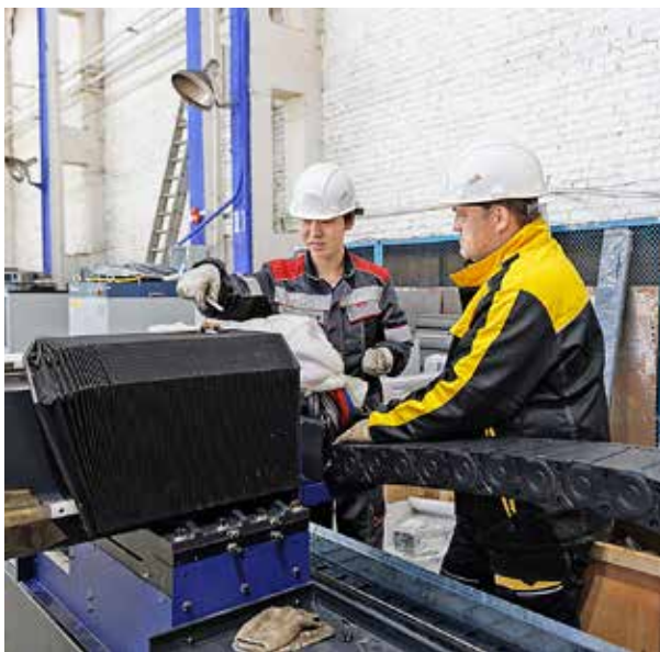
Монтаж лазера идет в 7 пролете цеха 48 Уралмашзавода
