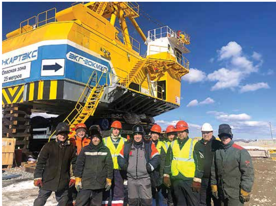
Первый ЭКГ-20КМ на Удокане бригада сервисного центра успела смонтировать до заморозков
